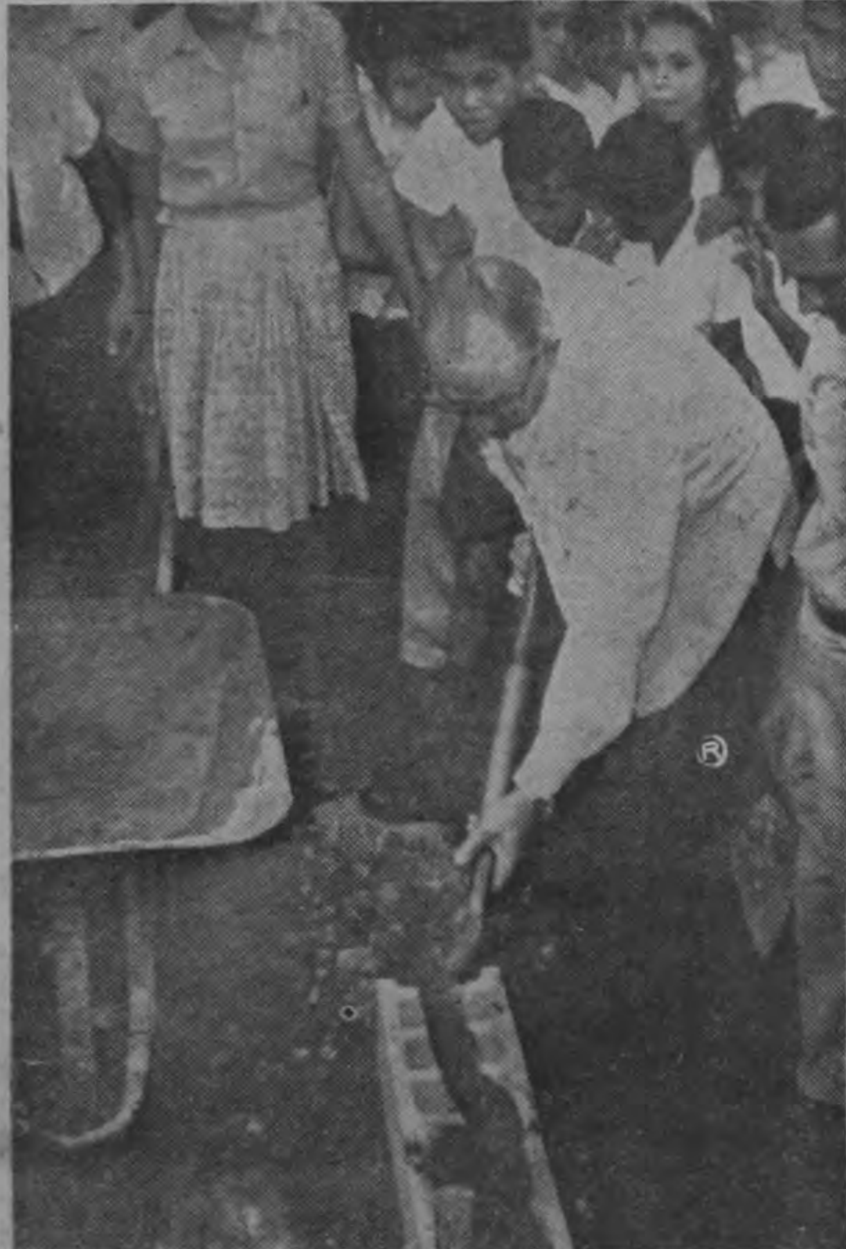
El Sr. Presidente coloca una palada de cemento para fijar la primera piedra de la construcción que albergará al Instituto Agropecuario que allí funcionará mediante un programa a auto-ayuda.
